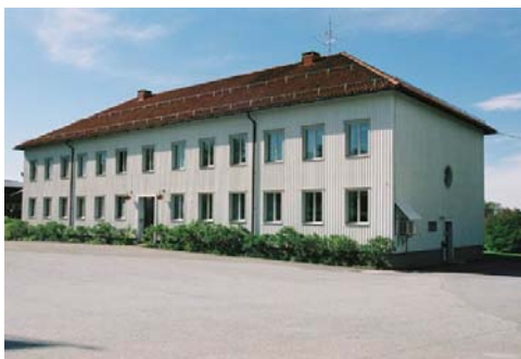
Till vänster ett foto från 1930-talet på det nyuppförda kanslibyggnaden med plant tak och putsade fasader. Fotot till höger visar hur byggnaden ser ut idag med valmat tak och panelinklädda fasader.
