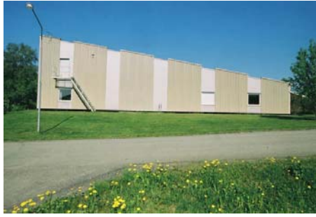
Det flacka pulpettakets ger byggnaden kilformade sidor.
