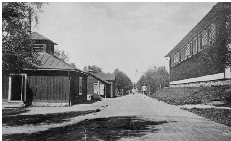
”Länergatan” med ett kokhus till vänster och exercishuset (F4’s gymnastikbyggnad) till höger.
