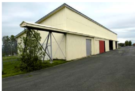
Flottiljens första hangarbyggnad, ”plåthangaren”, har fasader klädda med korrugerad plåt och är exteriört mycket välbevarad.
