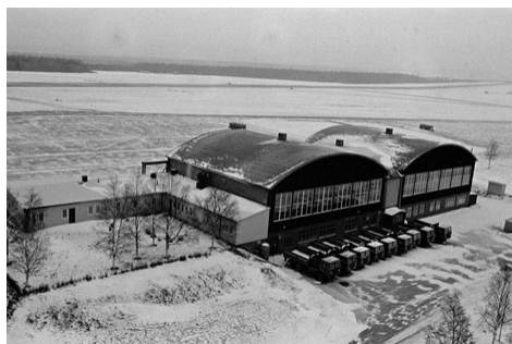
Foto från tidigt 1980-tal. Hangar 83 är byggd i en sluttning och har en souterrängvåning.
