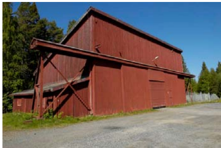
Den första sjöflygshangaren vid Kungsgårdsviken. Byggnaden är exteriört mycket välbevarad.
