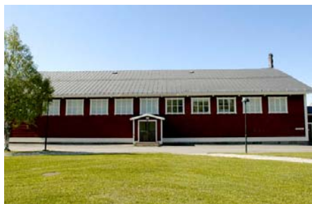
Byggnaden uppfördes som exercishus, men har under flottiljepoken använts som gymnastikhall.
