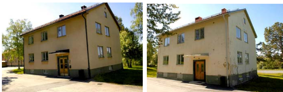
Byggnaderna 51 och 56 är till exteriören relativt oförändrade med flera välbevarade originaldetaljer.
