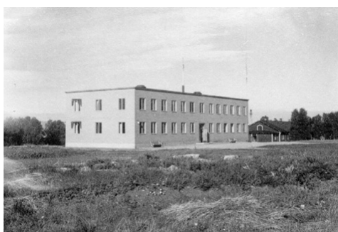
Till vänster ett foto från 1930-talet på det nyuppförda kanslibyggnaden med plant tak och putsade fasader. Fotot till höger visar hur byggnaden ser ut idag med valmat tak och panelinklädda fasader.
